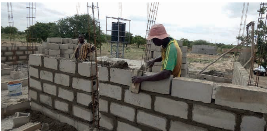
In alto a sinistra, Marisa, Maurizio e padre Bernard Yameogo. In alto a destra, la trivella per la ricerca di acqua. Sopra, la stalla in costruzione.
