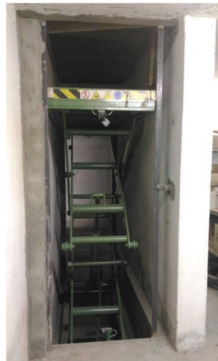
Posa in opera del capiente elevatore
